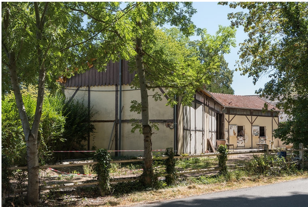
Vue depuis l'ouest.
