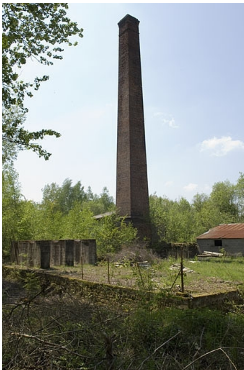
La cheminée vue depuis le nord-est.
