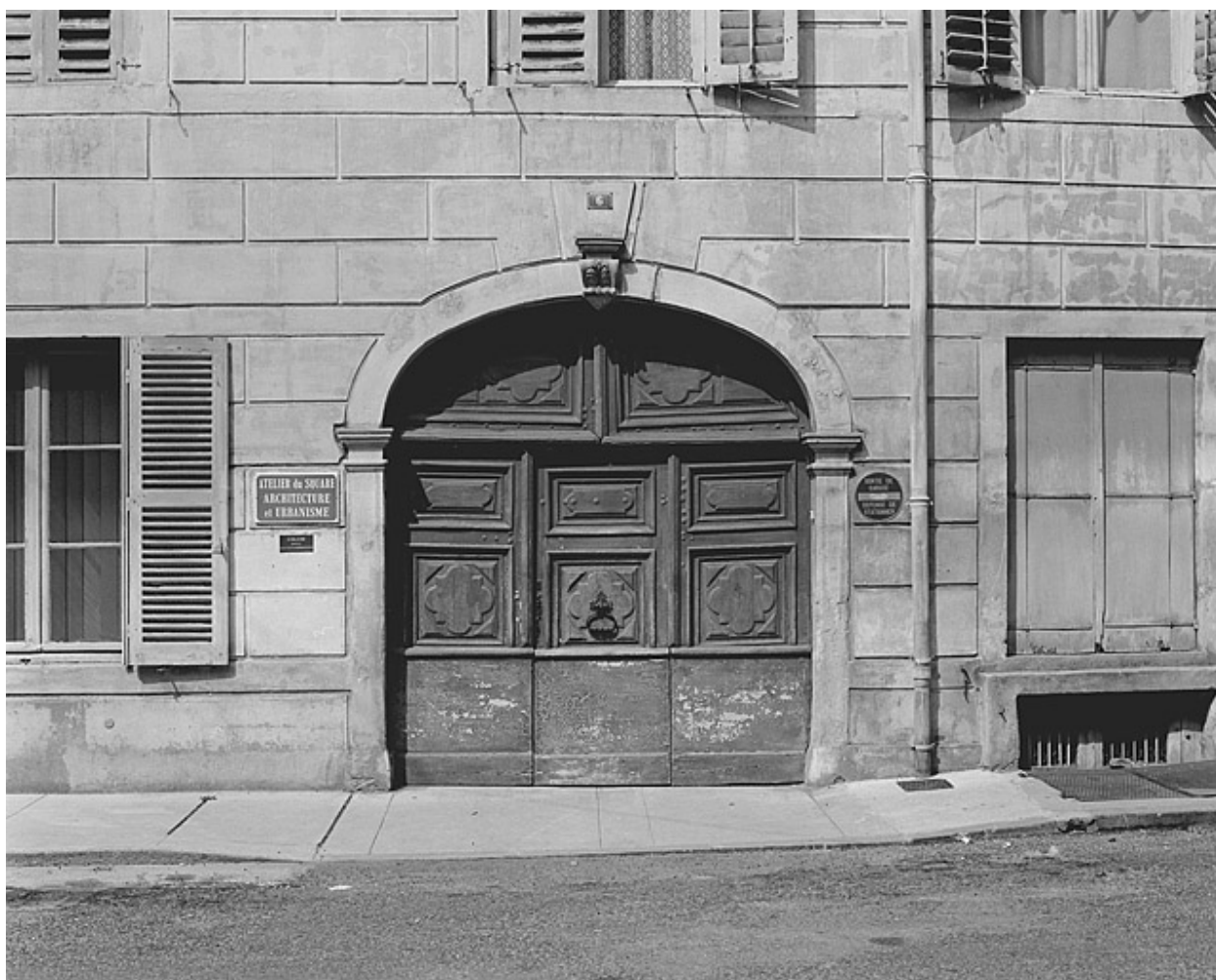
Portail de la façade antérieure.
