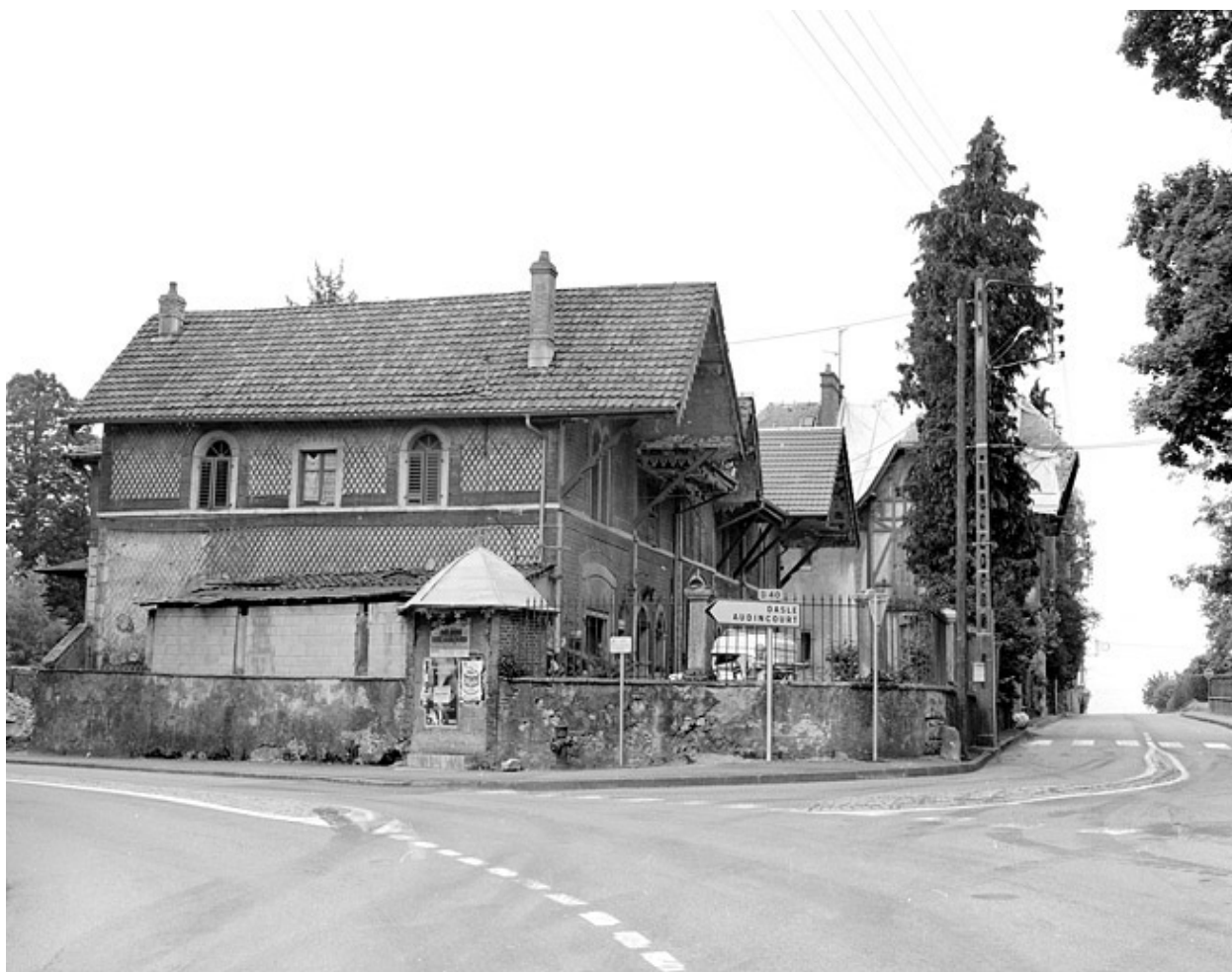
Façade orientale de la ferme.
