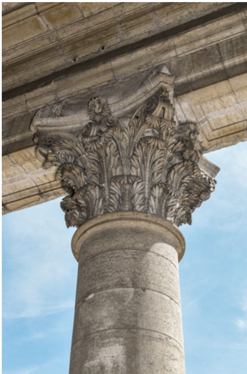
Façade antérieure : chapiteau d'une colonne.
