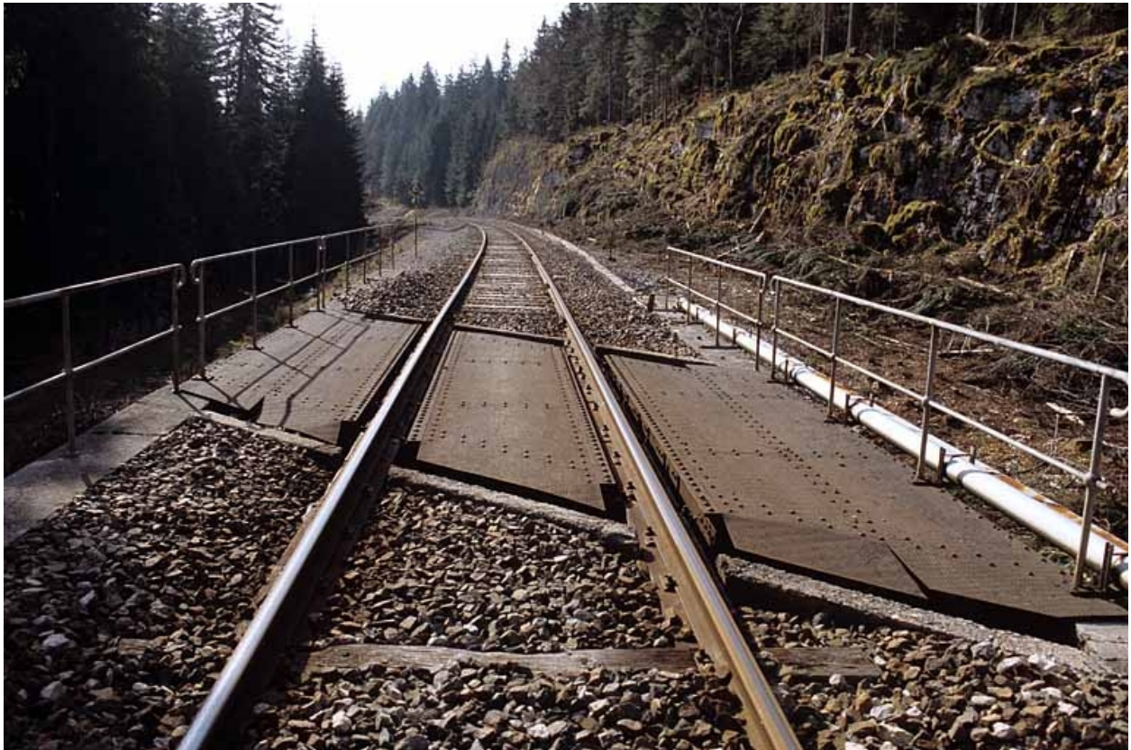
Tablier métallique, depuis la voie côté Andelot-en-Montagne.
