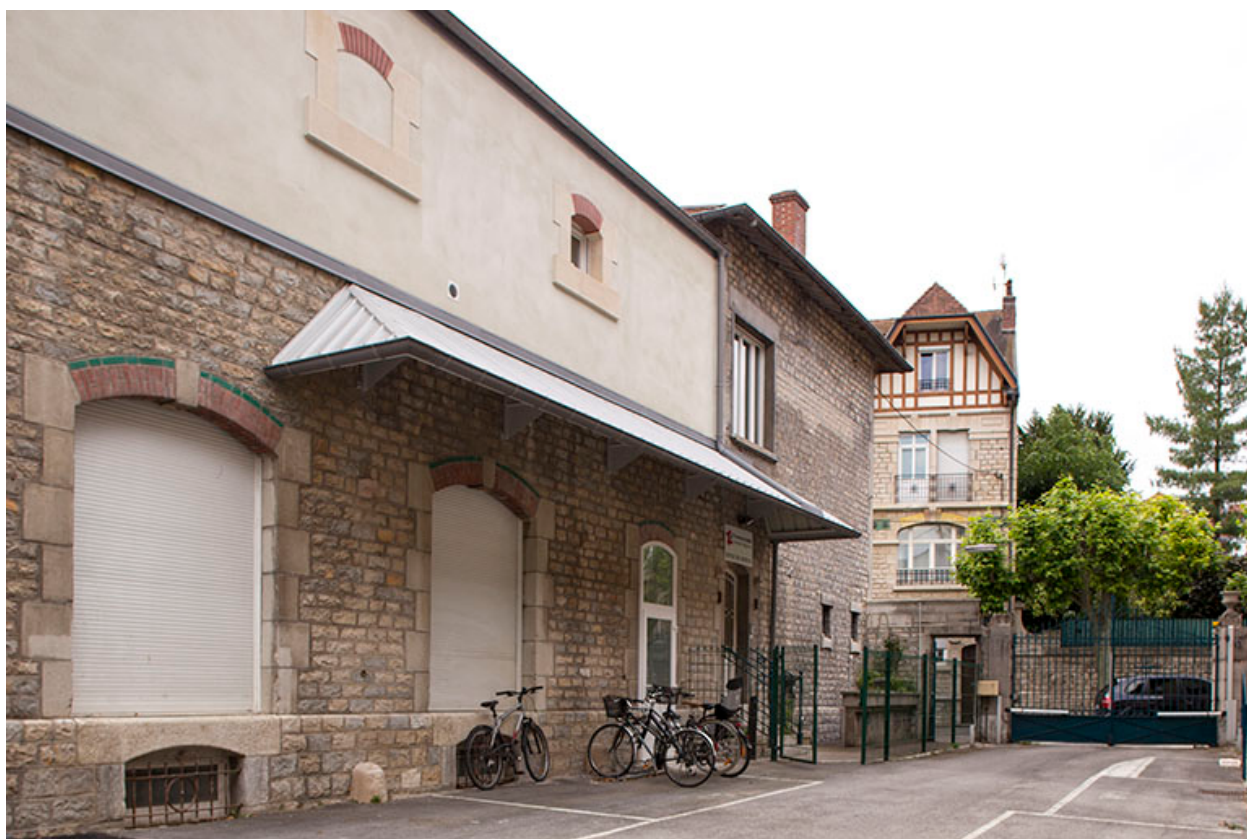
Entrepôt : façade antérieure de trois quarts gauche.
