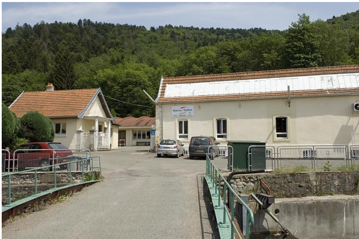
Vue d'ensemble depuis l'entrée du site.
