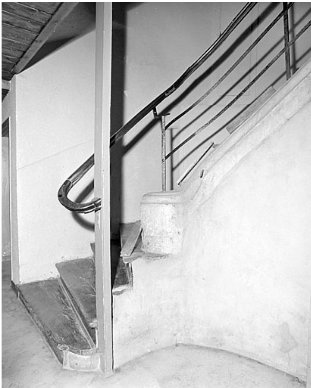
Escalier tournant : première volée.
