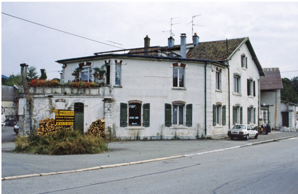
Vue d'ensemble depuis l'avenue de Schwabmünchen.
