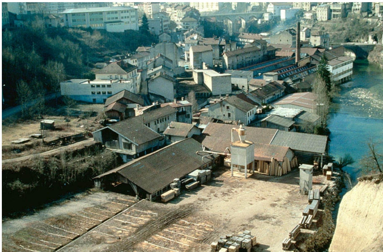
Vue d'ensemble plongeante depuis le nord.
