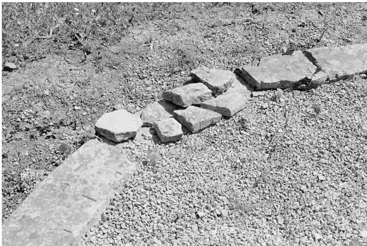
L'ellipse en pierre, avant restauration.
