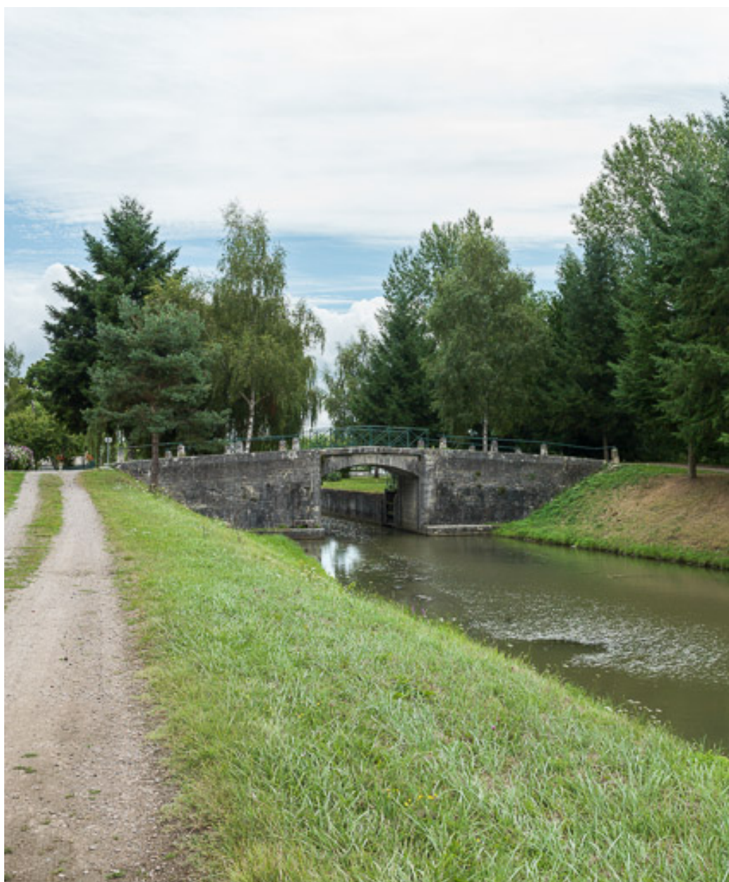
Vue d'ensemble du pont.
