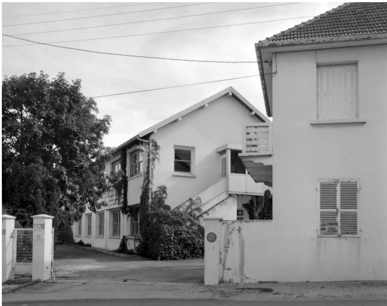
Entrée de l'usine, bureau et réfectoire.
