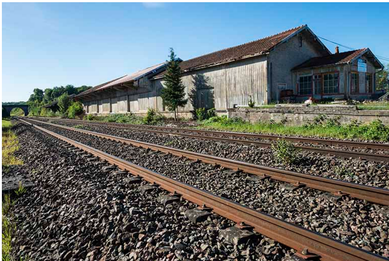
L'entrepôt de l'ancienne gare de Port-sur-Saône.
