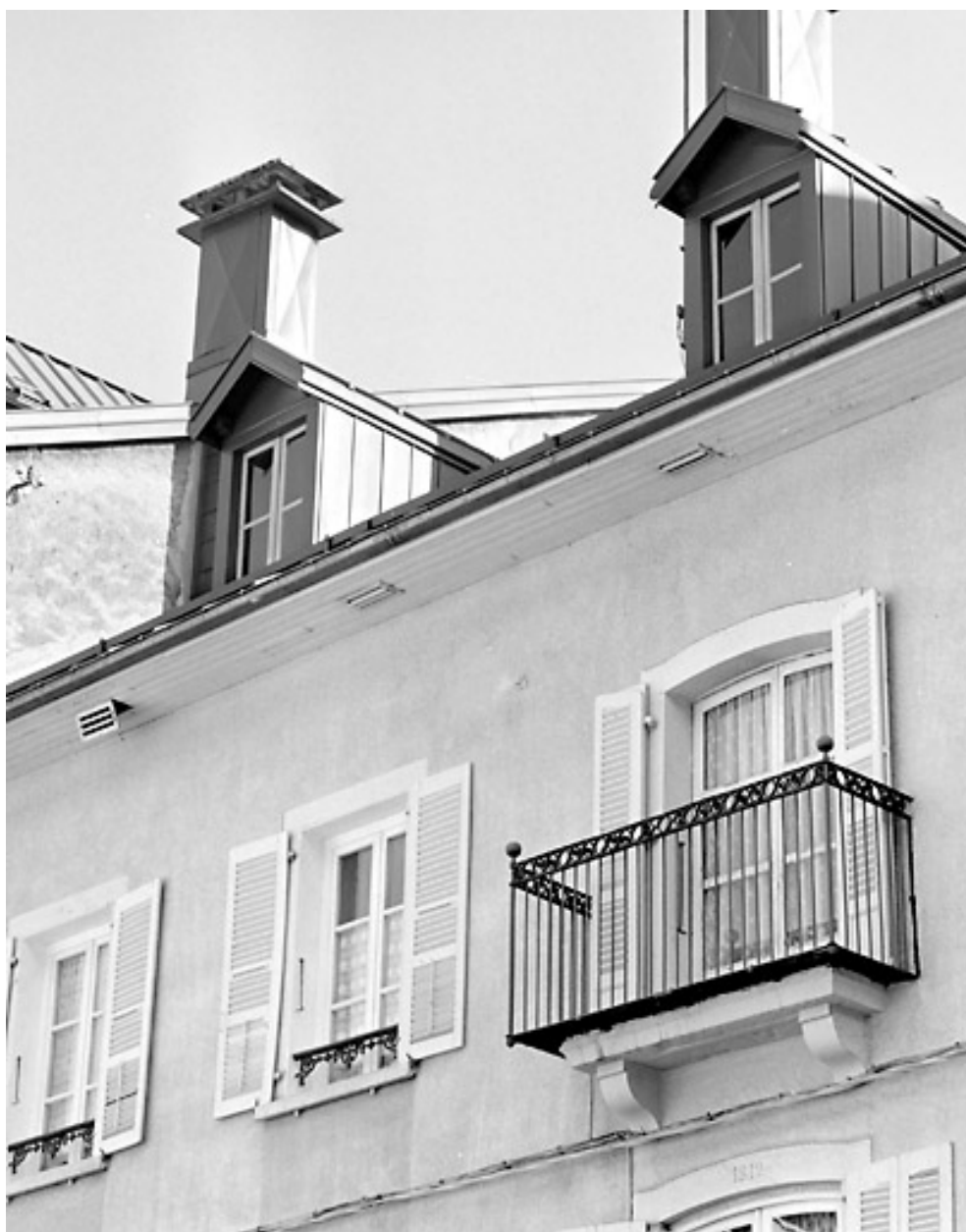
Fenêtres et balcon du deuxième étage.
