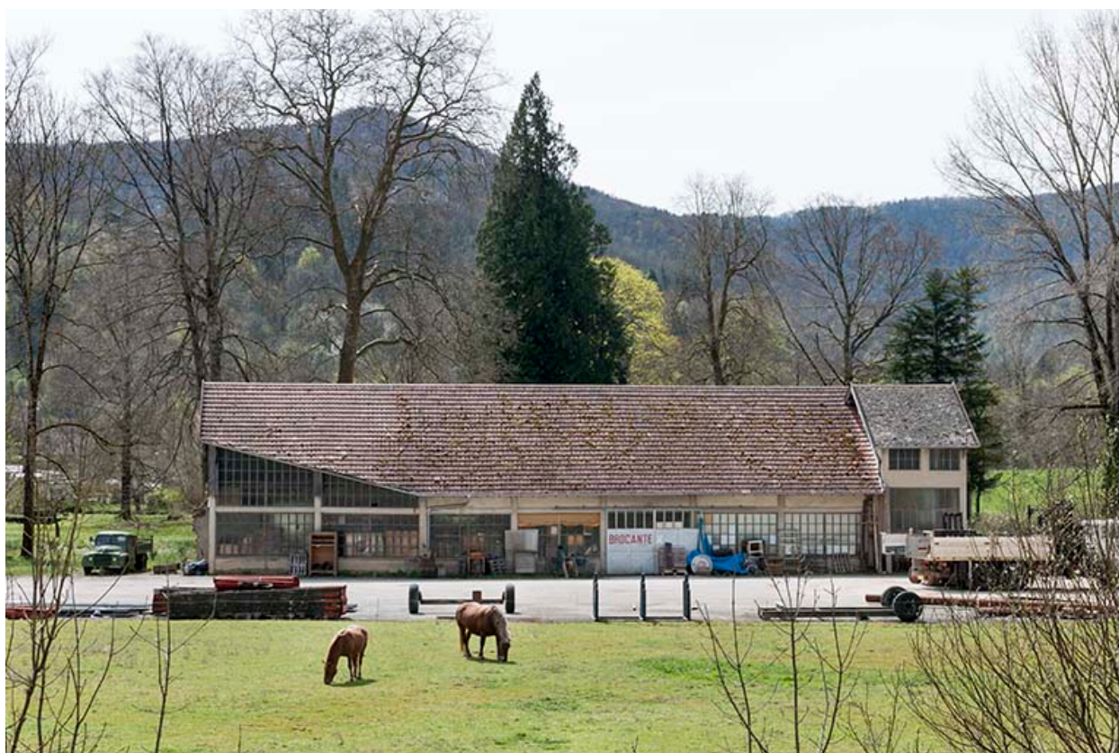
Atelier de mécanique.
