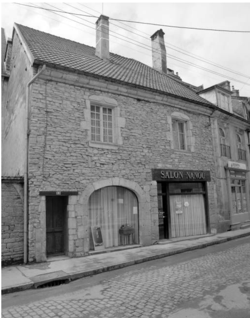
Maison située 9 rue Saint-Laurent.
