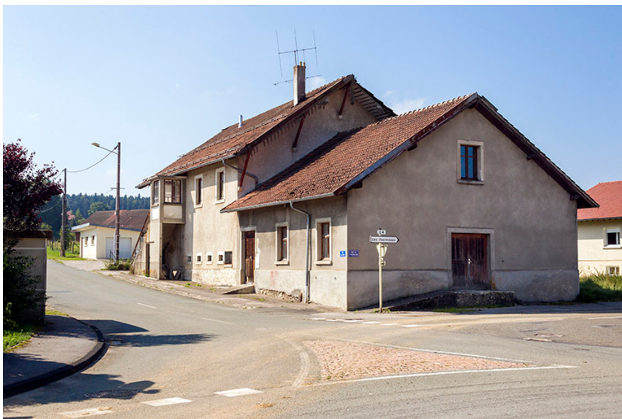
Façades postérieure et latérale droite.
