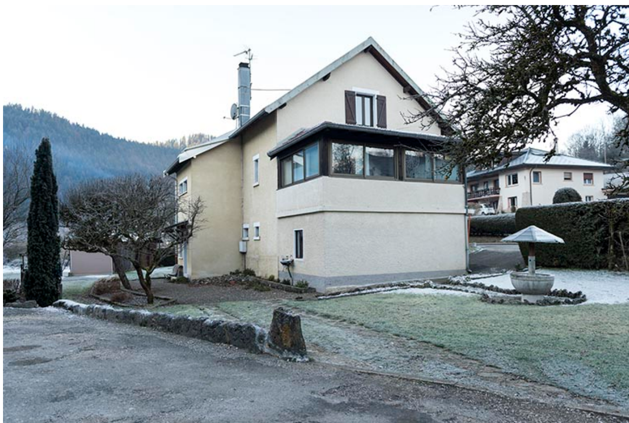
Façades postérieure et latérale gauche.
