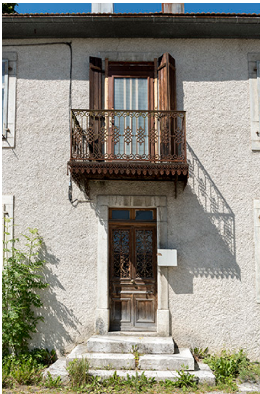
Façade antérieure : travée centrale.
