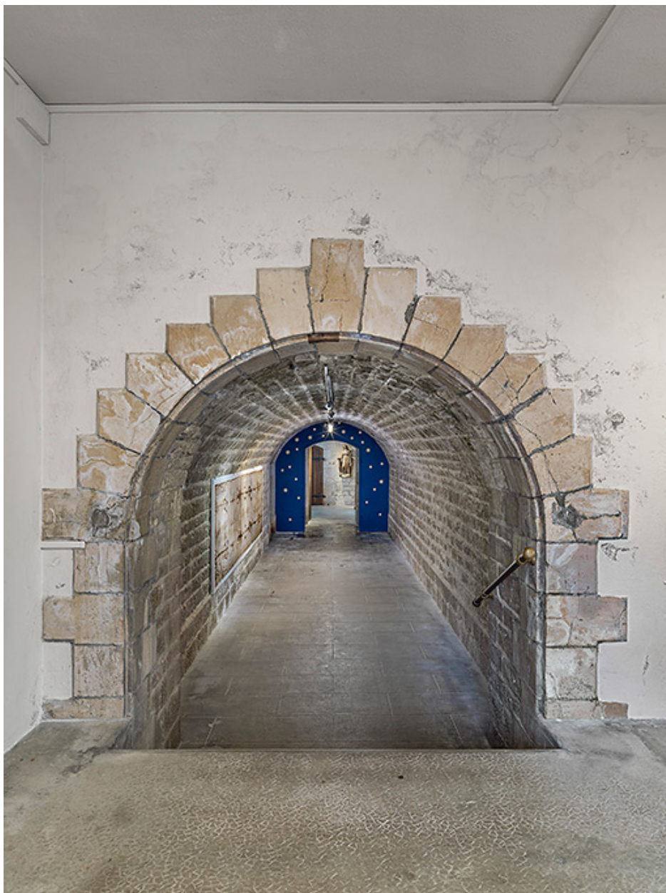
Porte d'entrée du magasin à poudre.
