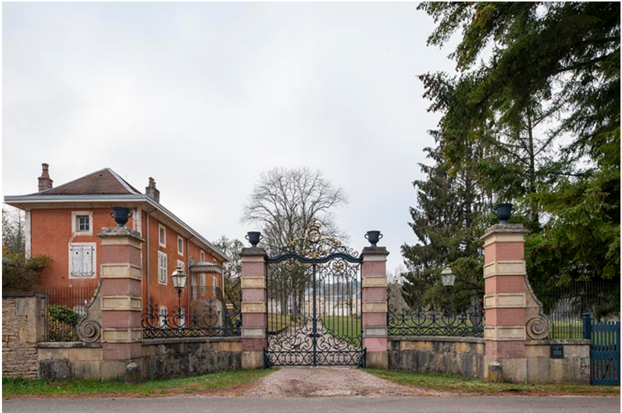
Clôture (grille) sur la rue de Saint-Albin.
