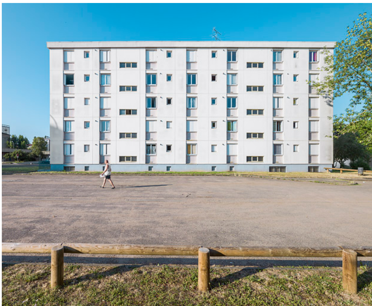
Bâtiment B-1, façade postérieure nord.
