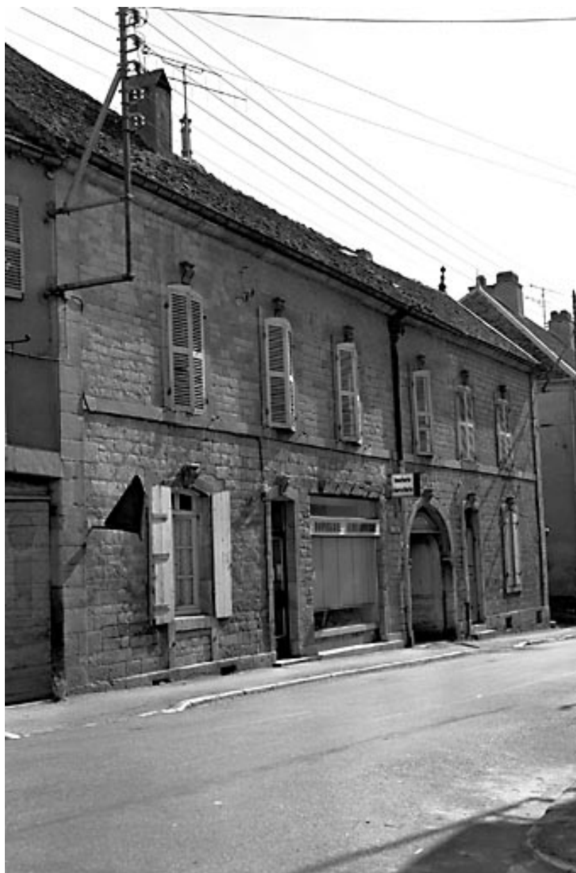
Façade antérieure en pierre de taille : vue de trois quarts gauche.
