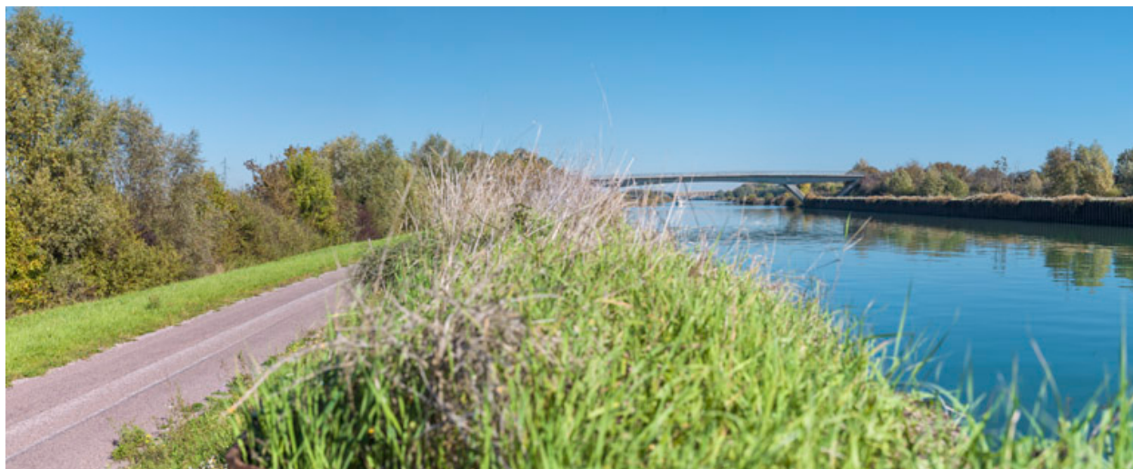
Vue d'ensemble, d'aval.
