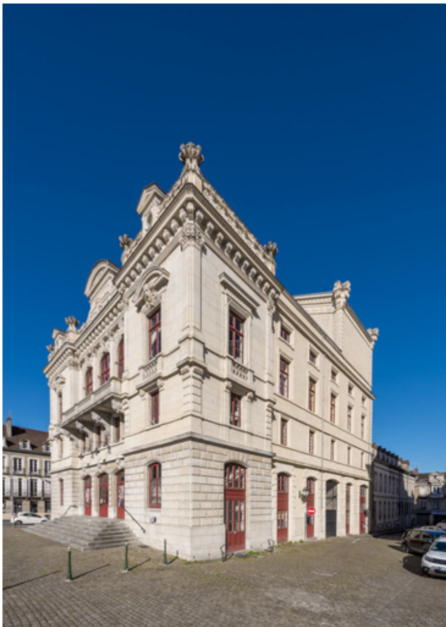
Façades antérieure et latérale droite.
