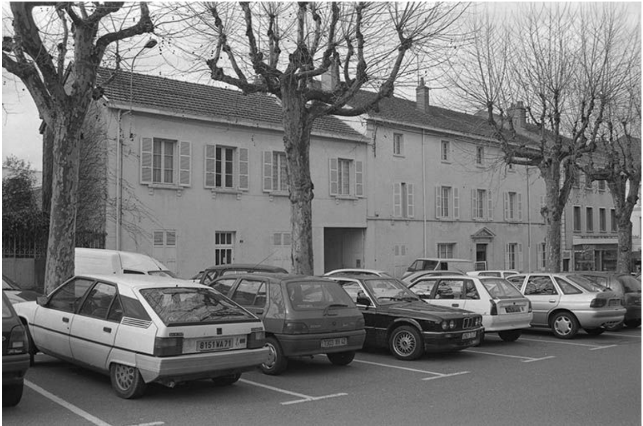
Façade antérieure du presbytère, vue de l'est.
