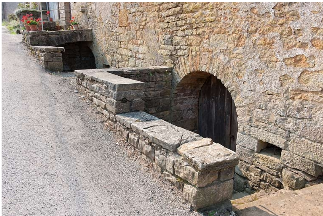
Accès aux caves.
