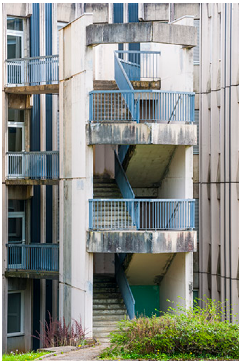
Détail de l'escalier extérieur de l'internat.
