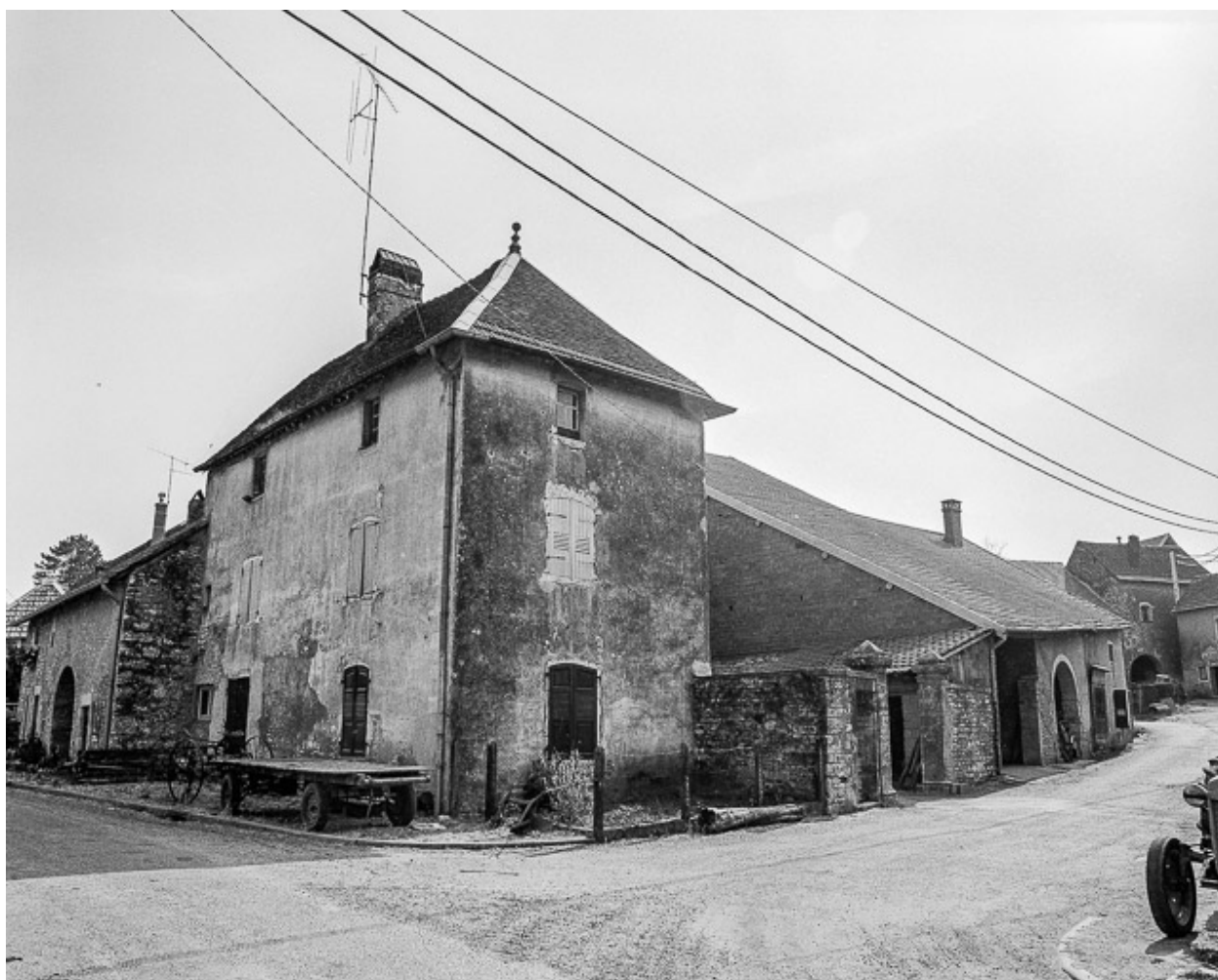
Maison située à l'angle de la rue d'Aval et rue de la Traverse.
