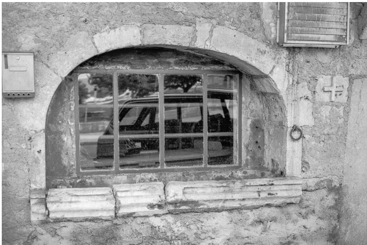
Fenêtre de l'écurie avec mangeoire.
