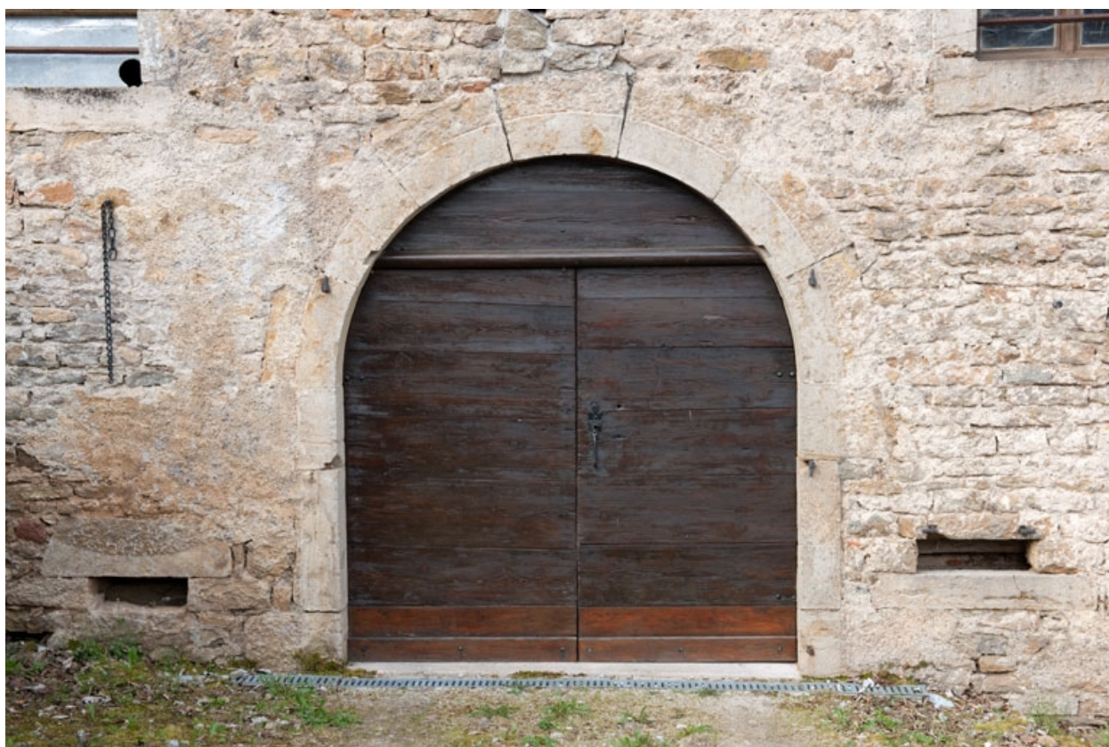
Grange : porte sur la façade latérale gauche.
