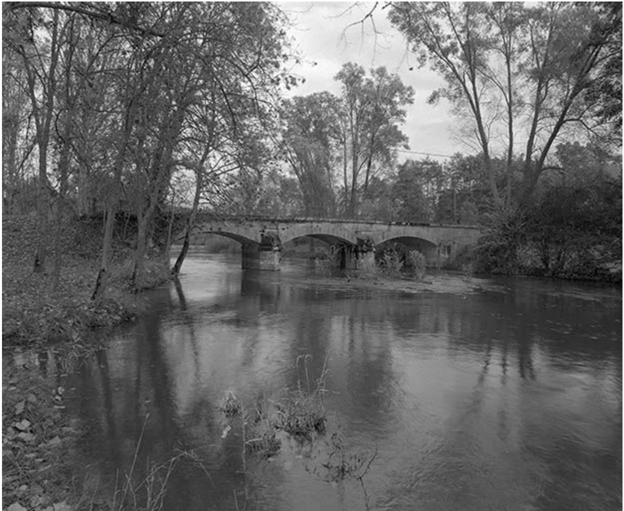
Vue prise depuis l'amont
