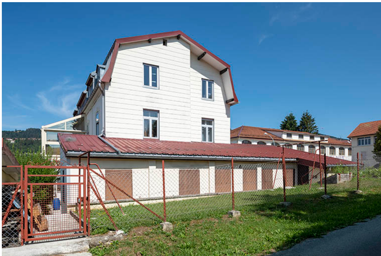
Façade latérale droite et atelier de fabrication.
