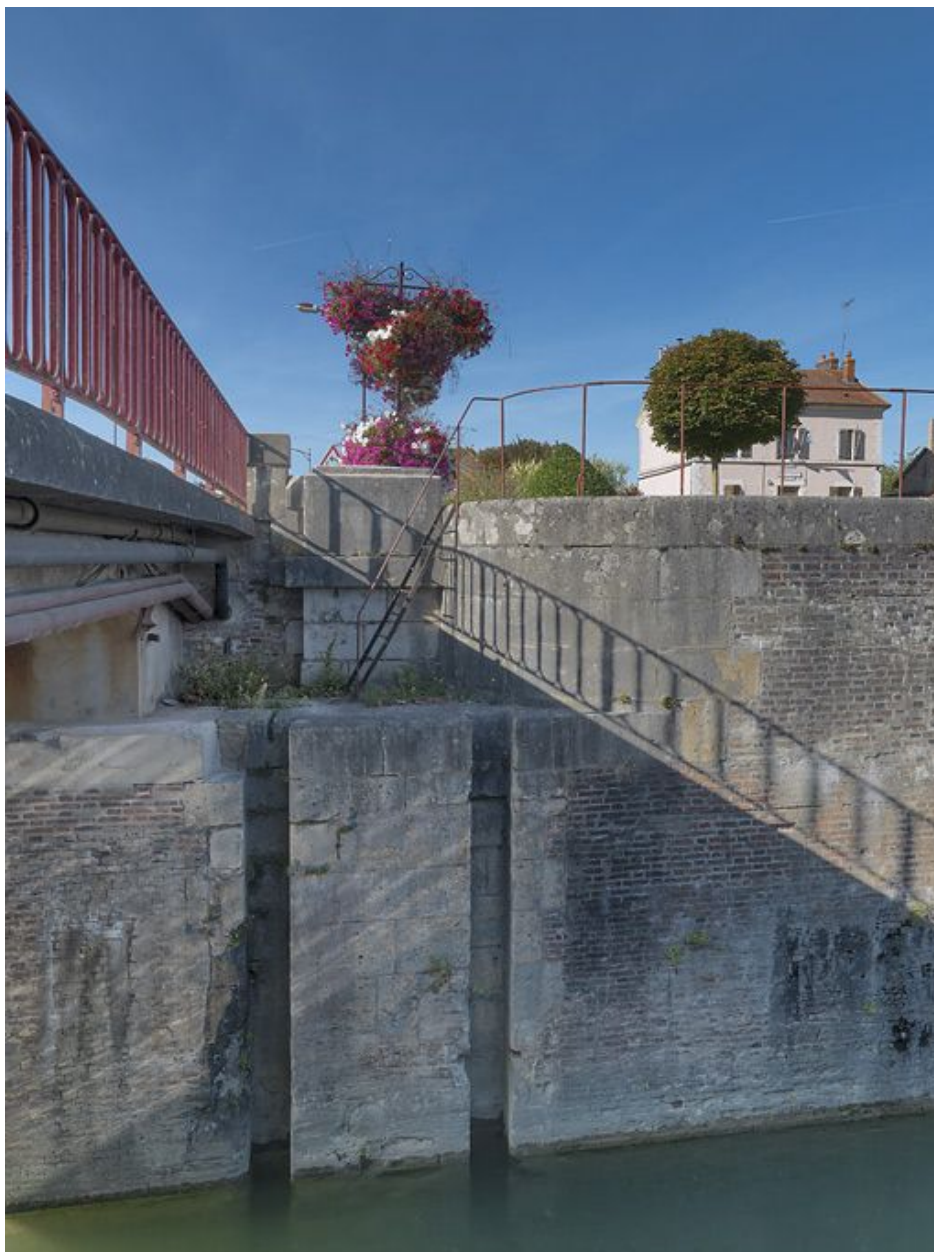
Le pont sur écluse : détail des maçonneries.
