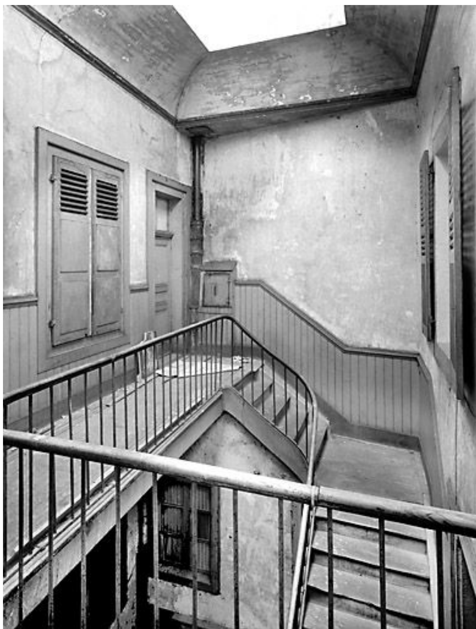
Palier du deuxième étage.
