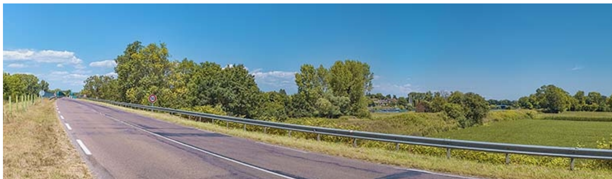
Chauvort et le pont, vue d'ensemble.
