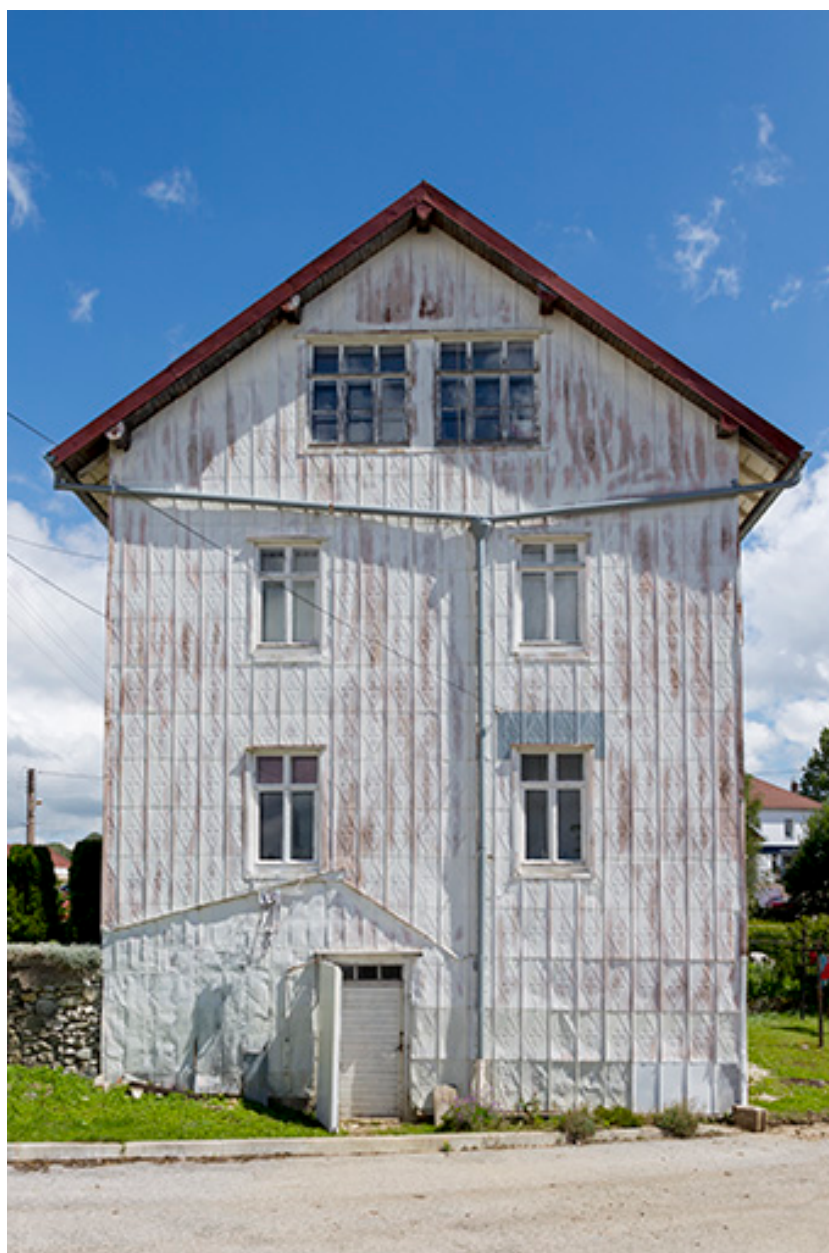
Façade latérale droite.
