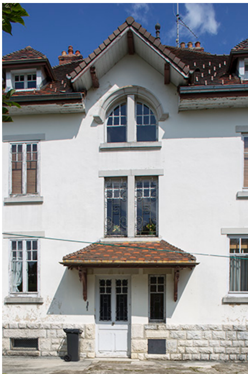
Façade latérale gauche : la travée centrale.
