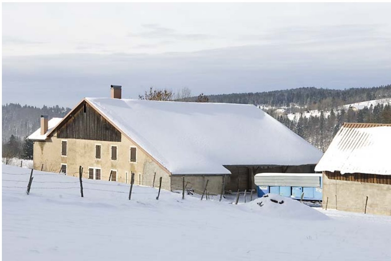
Façades postérieure et latérale droite, en hiver.
