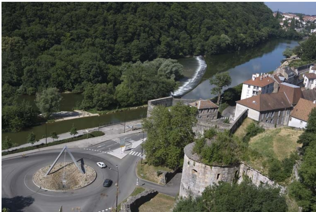
Vue d'ensemble plongeante sur le barrage.
