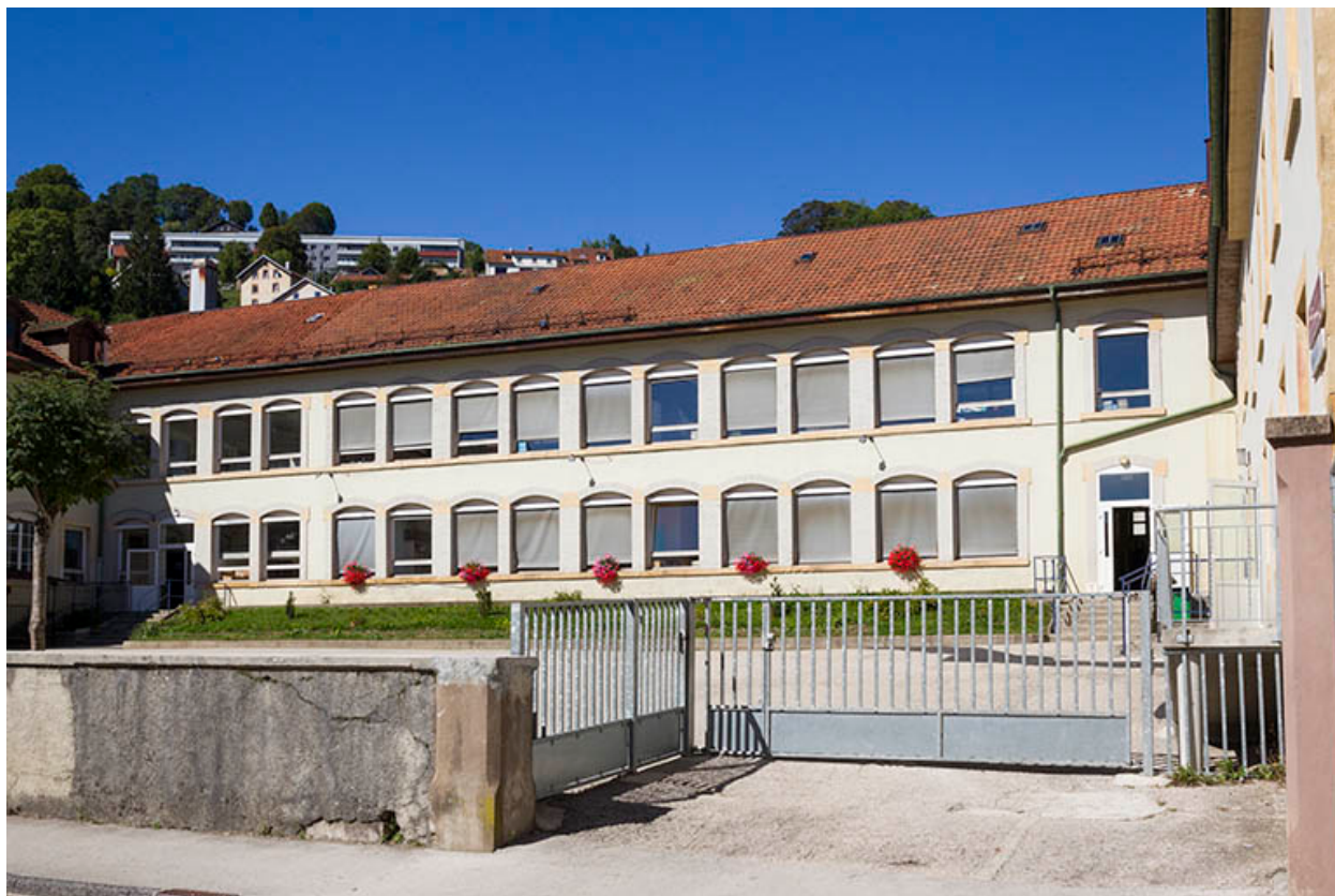
Aile nord : façade antérieure.
