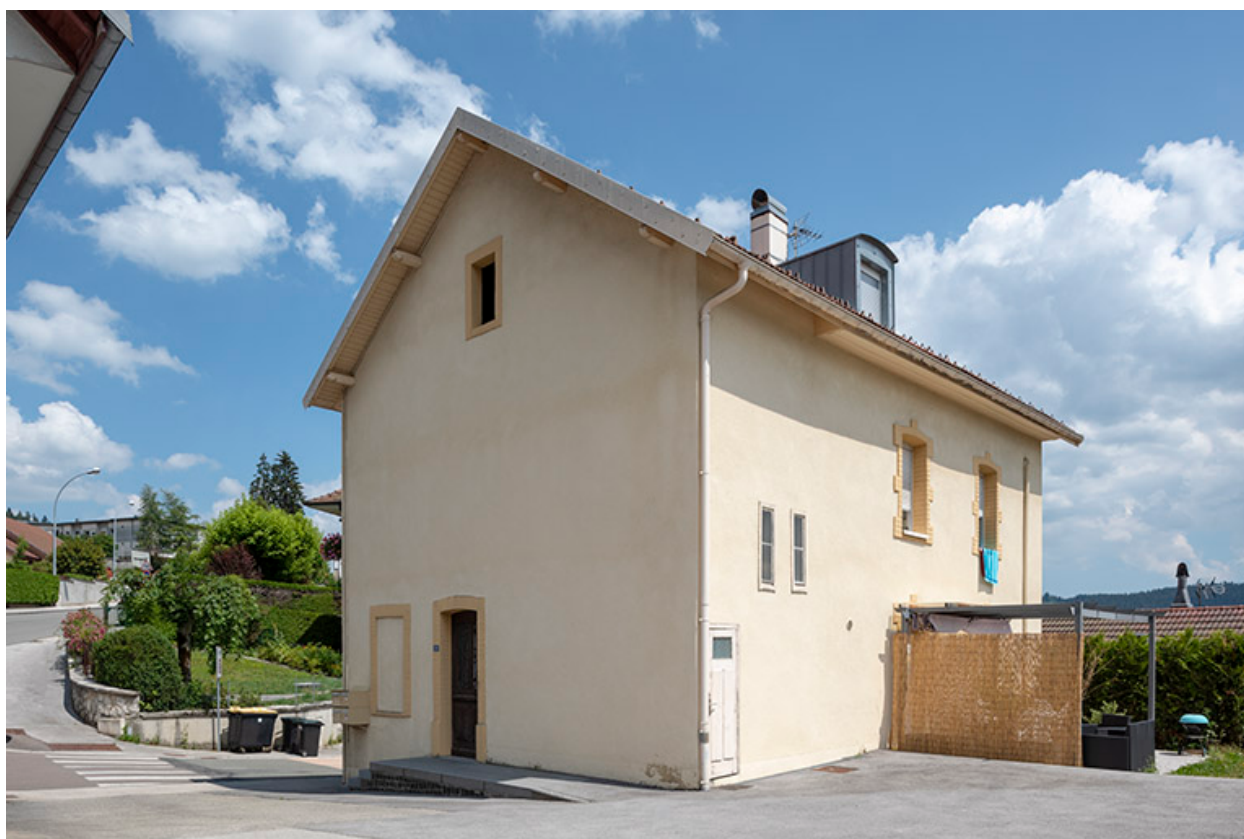
Façades postérieure et latérale droite.
