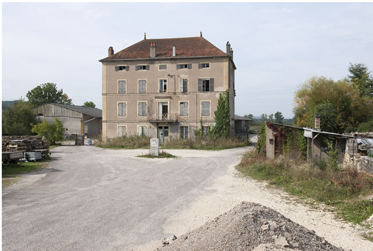
Vue générale depuis l'entrée.
