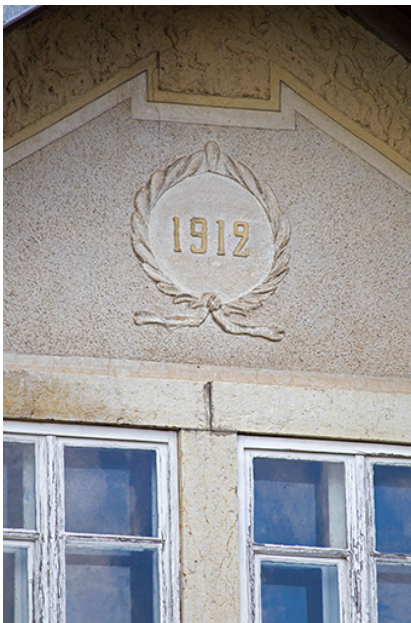
Façade latérale droite : date sur le pignon.
