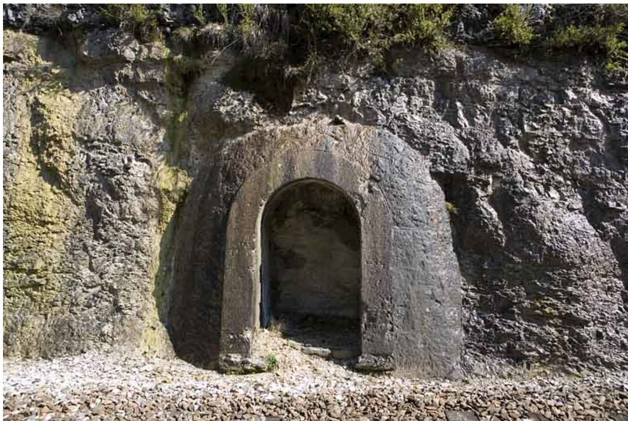
Cinquième abri (à gauche de la voie).
