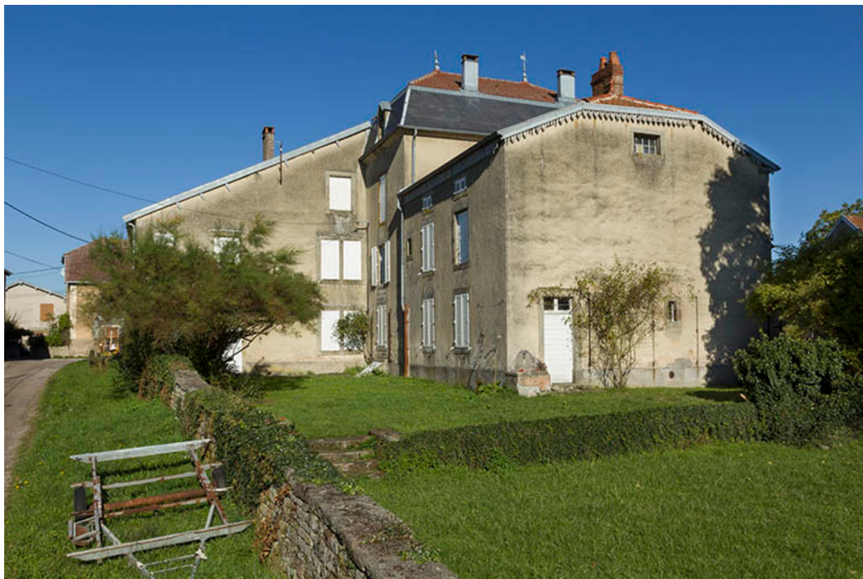
Maison, rue du Château, façades postérieures.
