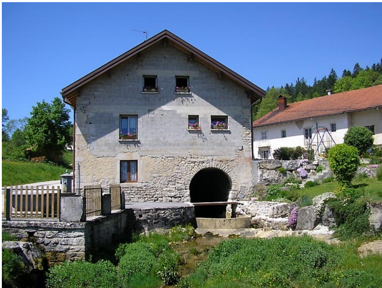
Scierie située au lieu-dit les Belbenoîts.
