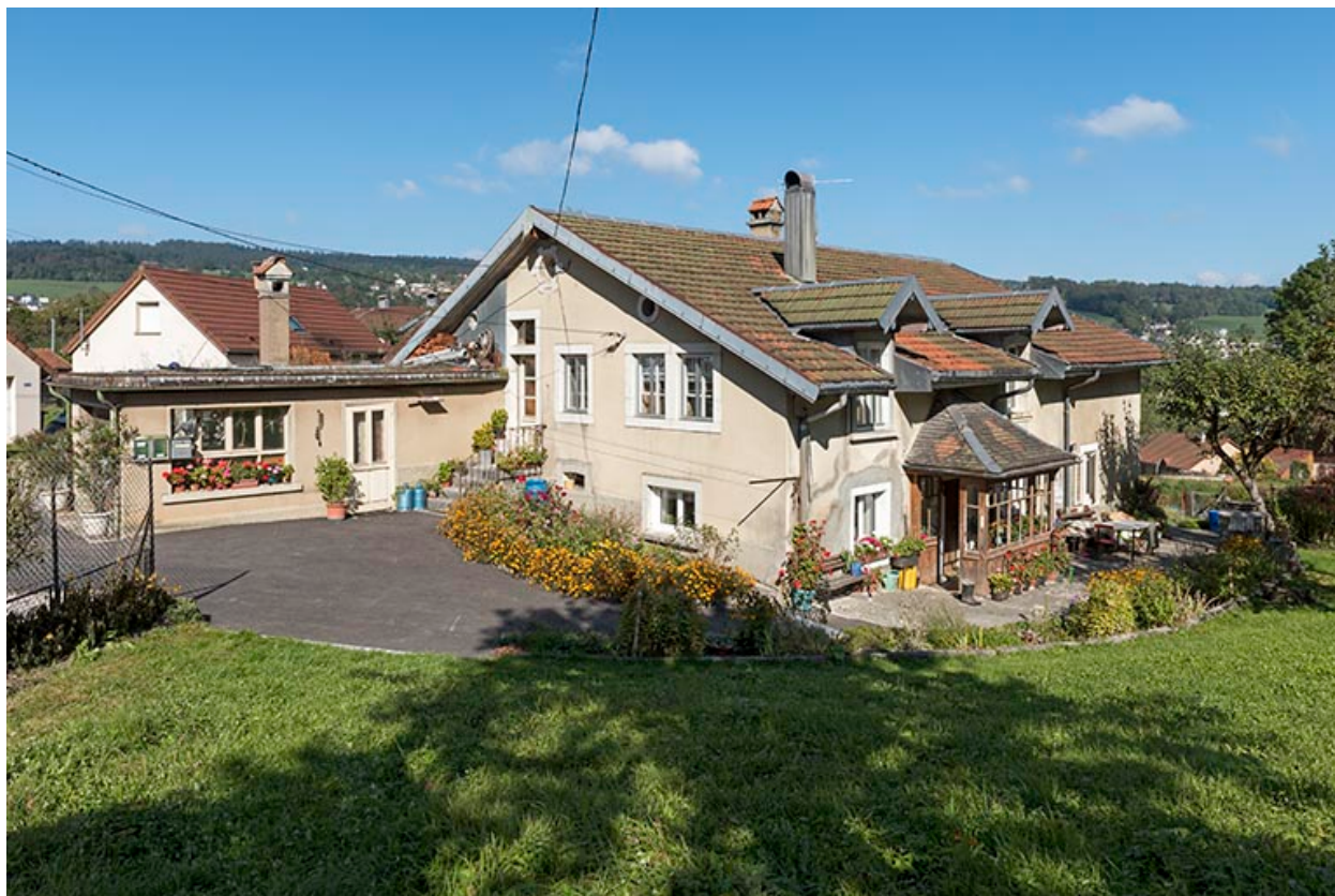
Façades postérieure et latérale droite.
